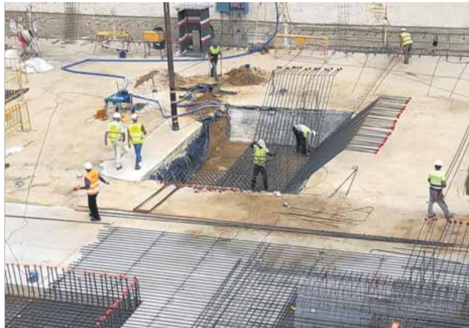
El calaix de formigó que ocupa l'edificació. A la dreta, els operaris preparant la base de la nova grua. A l'esquerra, les molles antivibracions ■ Ò. PINILLA / C. GIRONA
