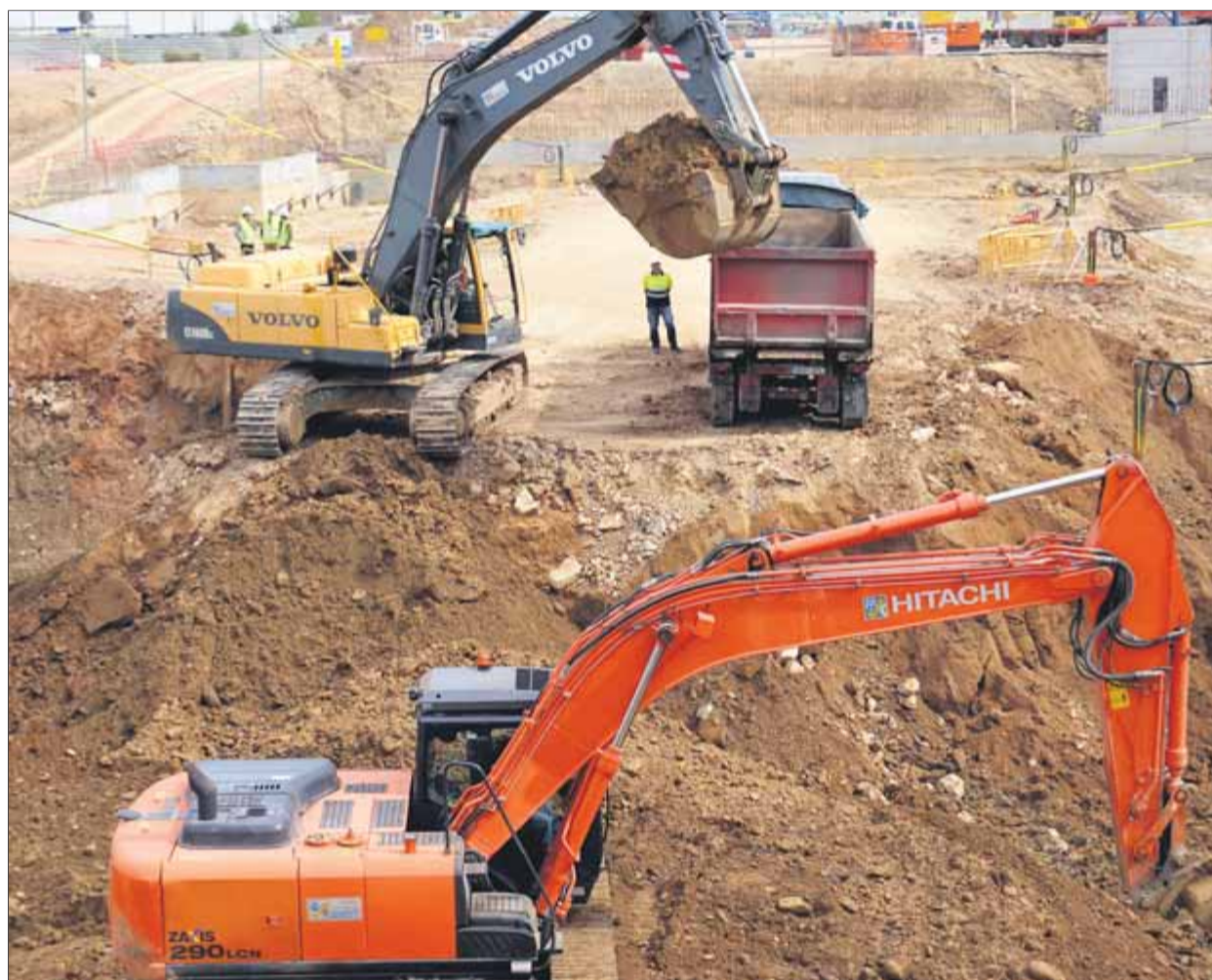
La zona d'obres de la futura clínica, en una imatge de divendres ■ CLÍNICA GIRONA
