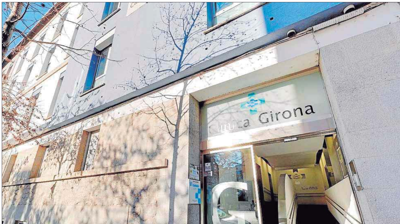
Façana del centre hospitalari, situat al carrer Joan Maragall. DcG
